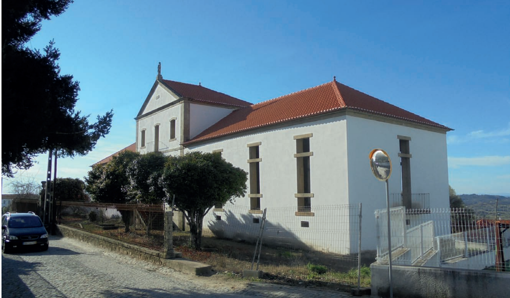
Antigo Hospital de Santo António – para evitar ruína, a estrutura do edifício foi estabilizada no início do século.
