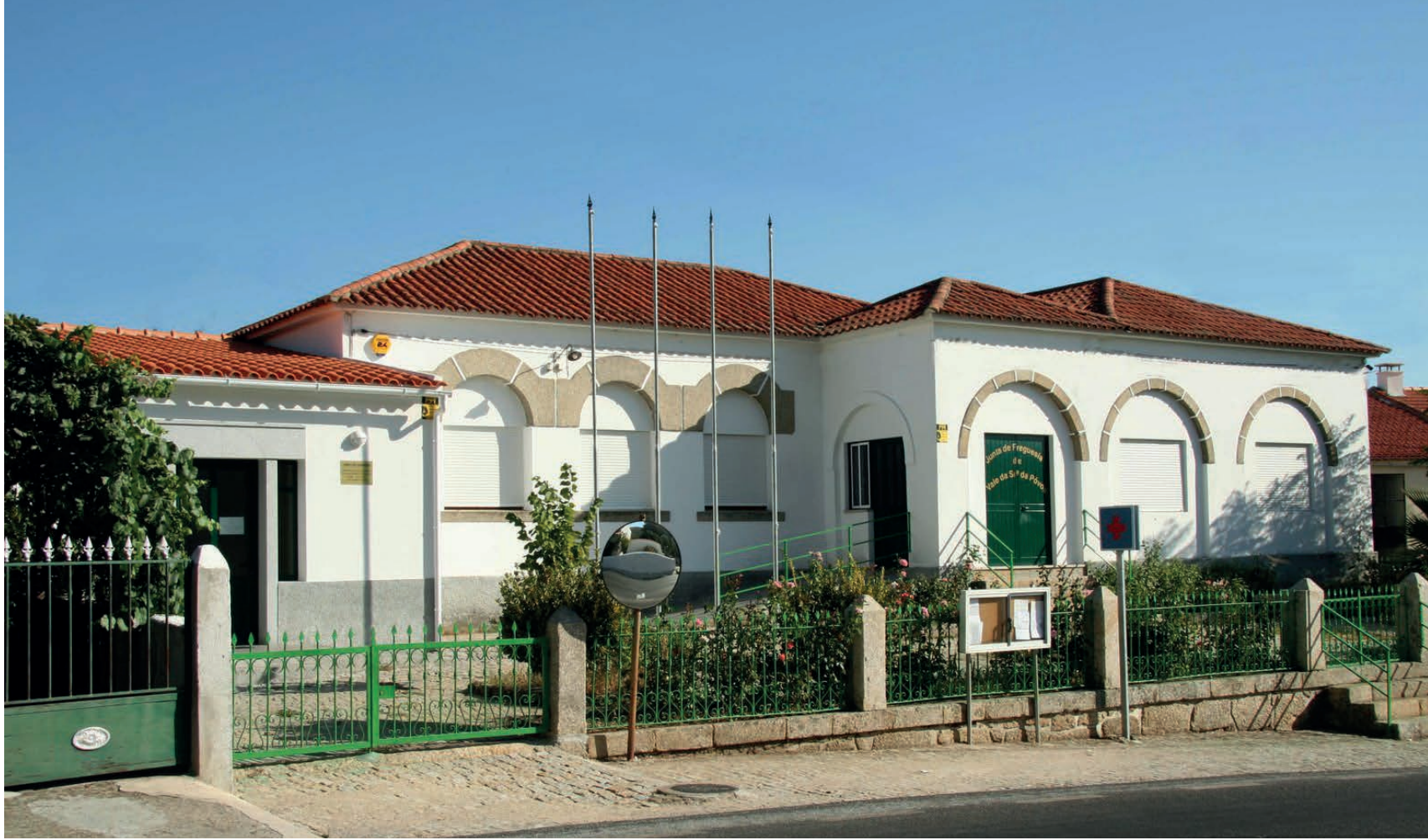
Edifício da Junta de Freguesia, Casa do Povo e Extensão de Saúde.
