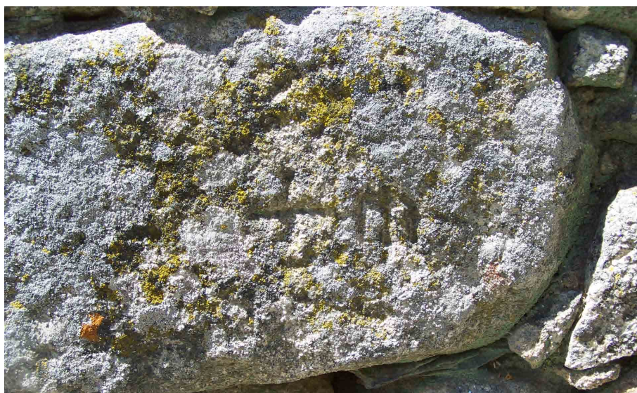
Rua do Relógio Pedra com cruz e letra (?) que hoje integra um muro, provavelmente deslocada de uma casa de habitação
