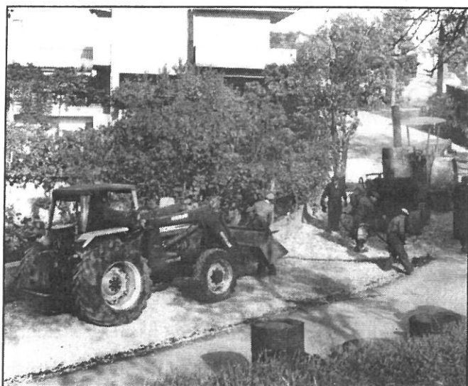
OBRAS NA E. M. 566 — ARANHAS
