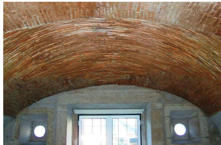
01 Aproveitamento do teto da capela do Real Hospital Militar S. João de Deus.
